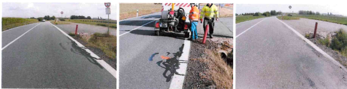
2019, 2020 (ošetřené podélné rozvětvené trhliny), 2022 (provizorní vysprávka v síťových trhlín, deformace)
