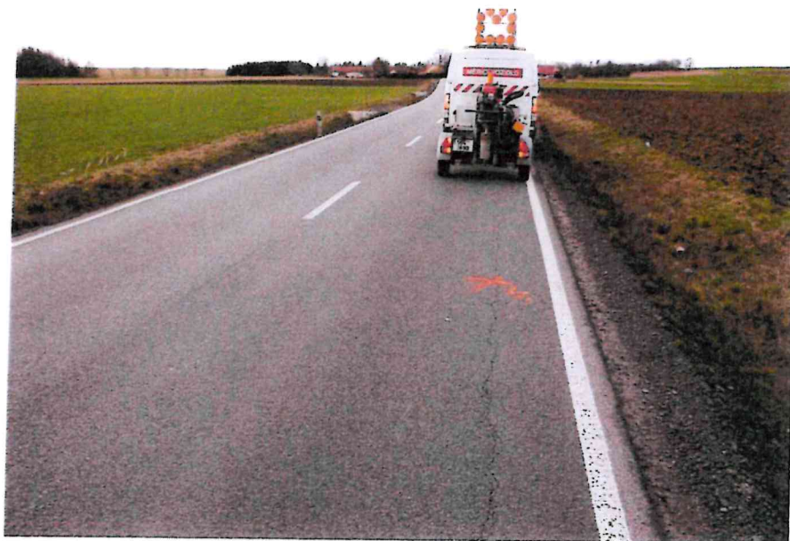
Obr.7: Podélná trhlina (stav k únoru 2020)
