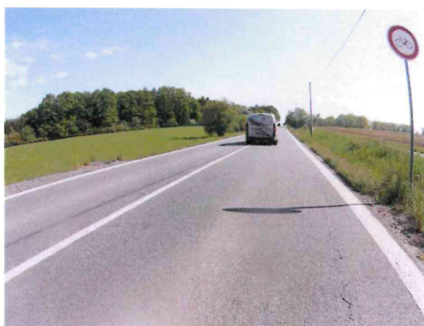
Podélná trhlina
