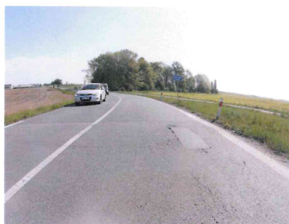
Konec úseku, mozaikové trhliny, vyspráva
