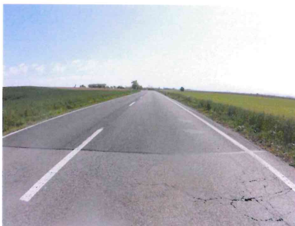
Konec úseku, výtluk, mozaikové trhliny
