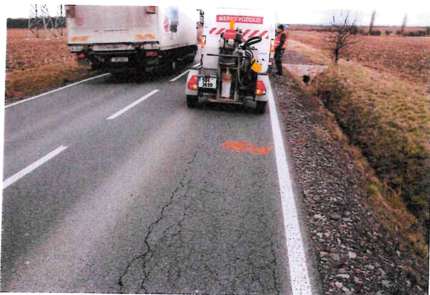
Obr.6: Mozaikové (síťové) trhliny (stav k únoru 2020)
