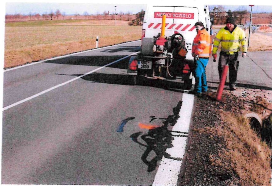
Obr.2: Podélné rozvětvené trhliny (stav k únoru 2020)
