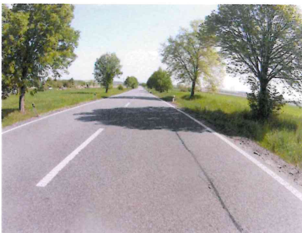
Podélná trhlina
