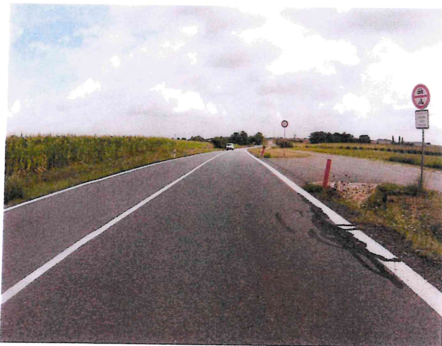
Obr.1: Podélné rozvětvené trhliny (stav k srpnu 2019)
