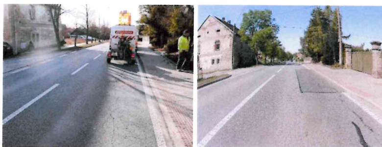
2020 (mozaikové / síťové trhliny, deformace), 2022 (síťové trhliny – vývoj před a za vysprávkou)
