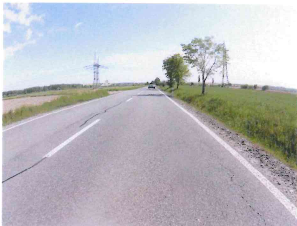
Podélné rozvětvené trhliny
