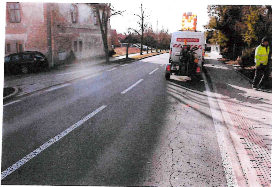
Obr.9: Mozaikové (síťové) trhliny (stav k únoru 2020)
