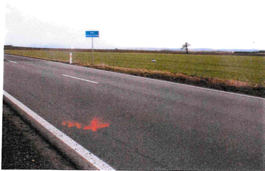
Obr.8: Podélná trhlina (stav k únoru 2020)
