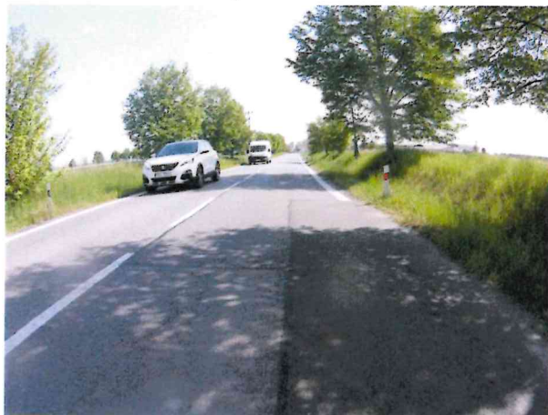
Začátek úseku, mozaikové trhliny, vyspráva
