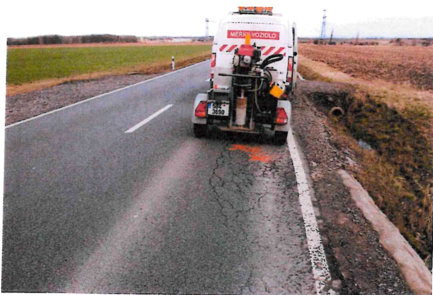
Obr.4: Mozaikové trhliny (stav k únoru 2020)
