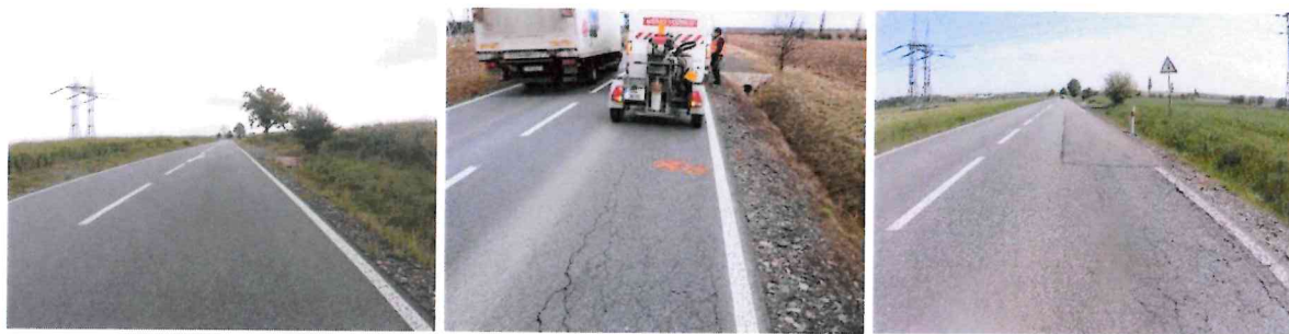
2019 (bez porušení), 2020 (síťové trhliny, deformace), 2022 (síťové trhliny – vývoj před a za vysprávkou)
